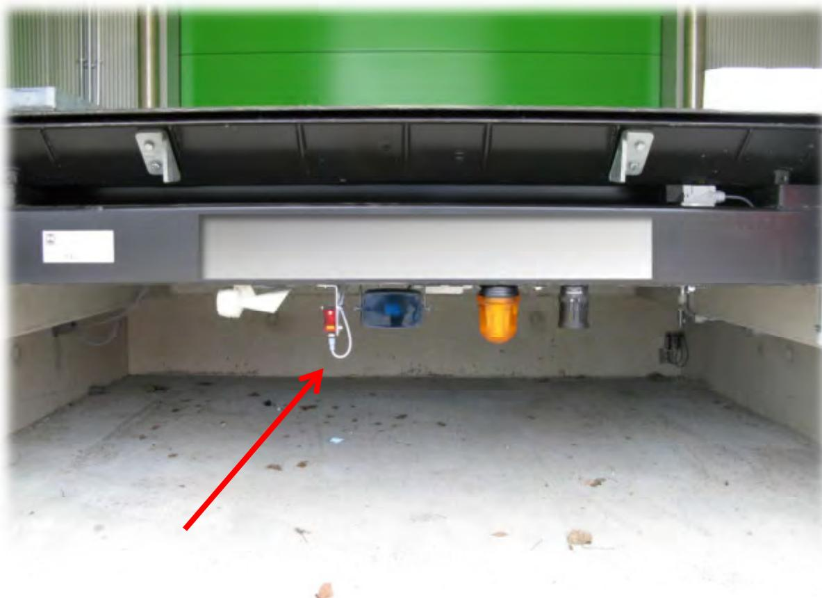
**Im Wechselbrückenmodus überwacht ein Lasersensor den Bereich zwischen den Stützen und entriegelt nur dann das Tor, wenn kein Trägerfahrzeug unter der Wechselbrücke erkannt wird.**
