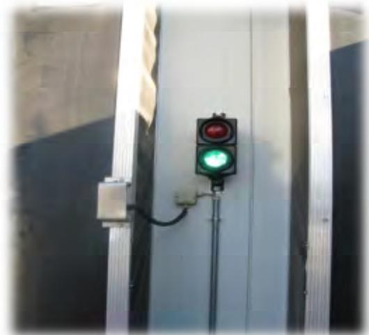
Ein Positioniersystem unterstützt den LKW-Fahrer während der Positionierung und informiert ob das Fahrzeug nahe der richtigen Position (rot blinkend) ist.
