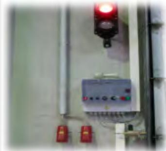
Wenn ein LKW-Fahrer versucht, den Schubert LRS Radkeil während der Verladung zu entfernen, warnen sofort akustische und visuelle Signale im Innen- und Aussenbereich die LKW-Fahrer und das Verladepersonal. Die Verladung kann rechtzeitig und gefahrlos unterbrochen werden.
