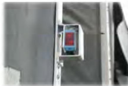
Ein Lasersensor dedektiert Fahrzeuge innerhalb einer einstellbaren Entfernung vor der Verladestelle und warnt Fußgänger in der Gefahrenzone zwischen Fahrzeug und Gebäude mittels akustischem Signal und orangenem Blitzlicht.
