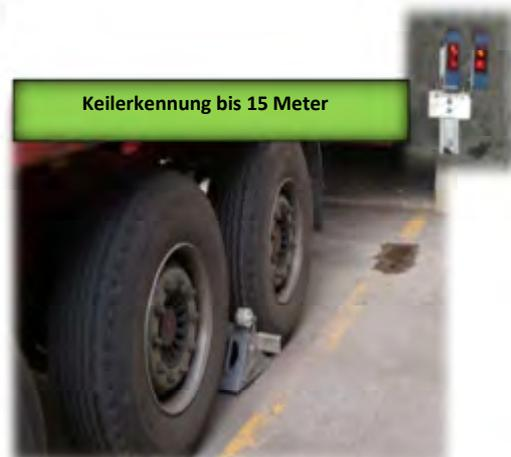
Ein Sensor auf dem Verladewetterschutz überwacht ob sich Fahrzeuge in der korrekten Position vor der Verladestelle befinden.
