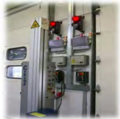
Der Radkeil wird von den Lichtschranken automatisch erkannt. Hierdurch erfolgt die Richtungserkennung des Radkeiles. In Verbindung mit dem Funksignalgeber erfolgt gleichzeitig die Freigabe für das Tor oder die Überladebrücke.
