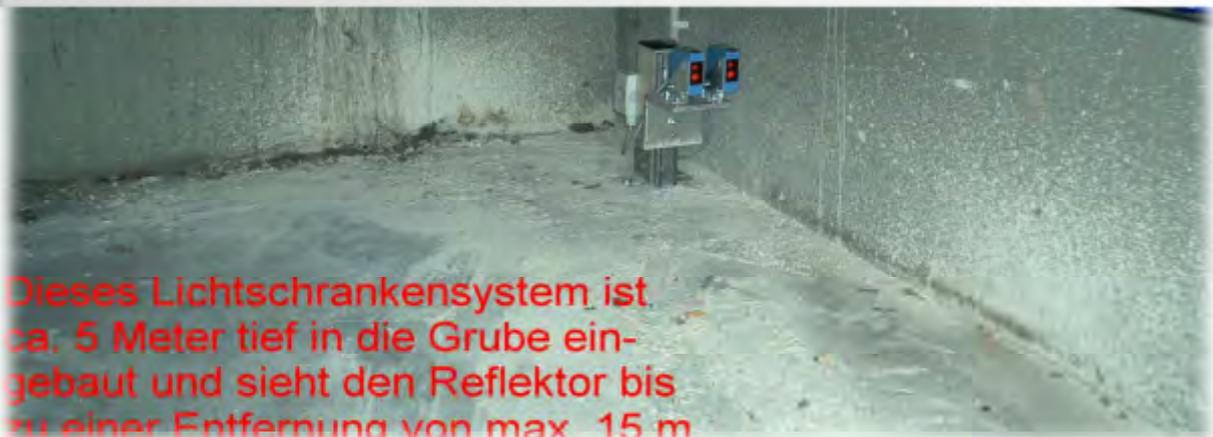
Dieses Lichtschrankensystem ist ca. 5 Meter tief in die Grube eingebaut und sieht den Reflektor bis zu einer Entfernung von max. 15 m
