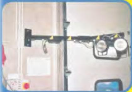
Die Konstruktion selbst besteht aus zwei Scheinwerfern, die sich an einem gelenkig- und kunststoffgelagertem Vierkantrohr befinden, das wiederum im Bereich der entsprechenden Laderampe montiert wird.
